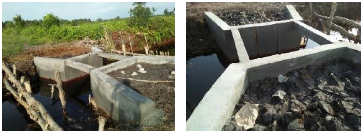
Gambar 28. Pembangunan pintu tabat permanen pada saluran tersier demplot lahan sawah pasang surut Tamban Baru Tengah
