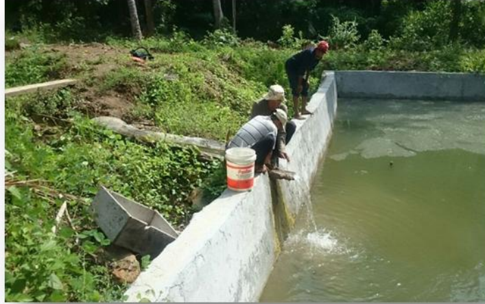
Gambar 11. Pengukuran debit inlet embung di Desa Mappesangka, Kecamatan Ponro, Kabupaten Bone, Sulawesi Selatan
