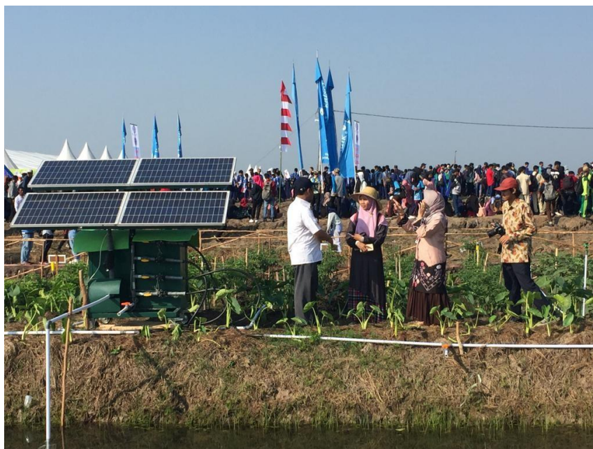
Gambar 3. Pompa radiasi surya tanpa untuk jaringan irigasi mikro
