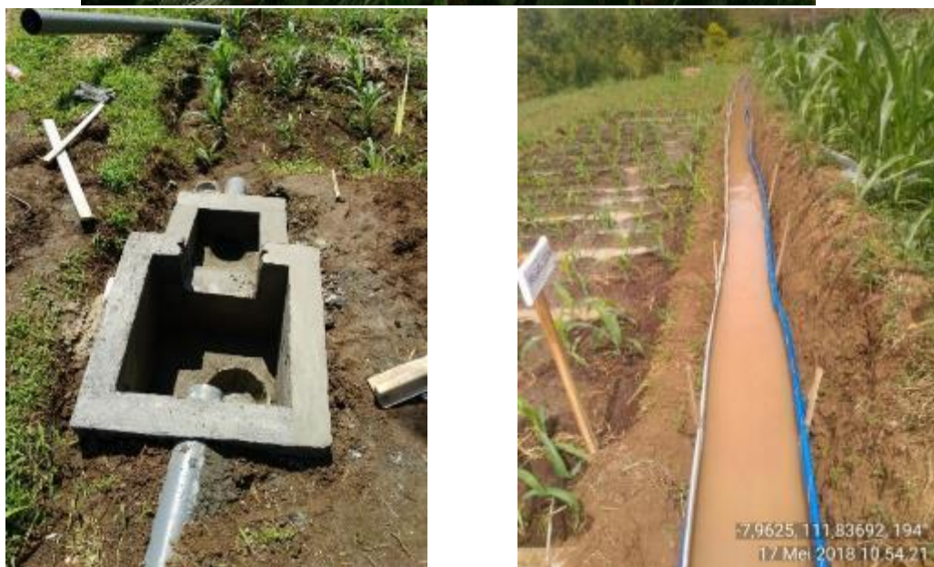
Gambar 24. Pembuatan bendung penduga debit ( weir ) dan pelapisan saluran dengan terpal plastik pada Demplot perlakuan irigasi tanaman jagung
