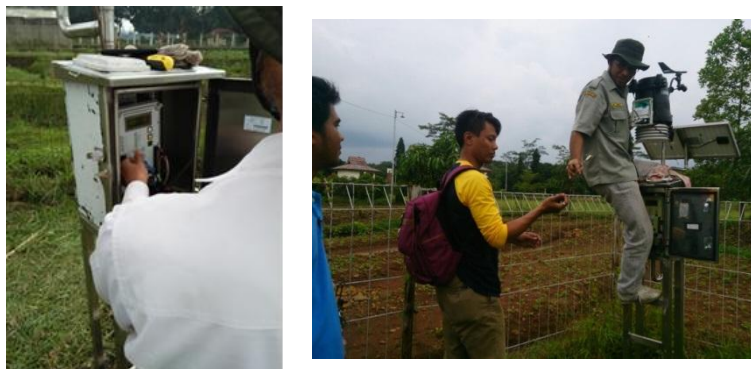
Gambar 90. Pengecekan, penggantian simcard dan pemeliharaan AWS Telemetri Lembang, Bandung dan Sedong, Cirebon
